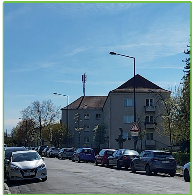
Mobilfunkantenne Industriestraße 28, Foto: WGTN
