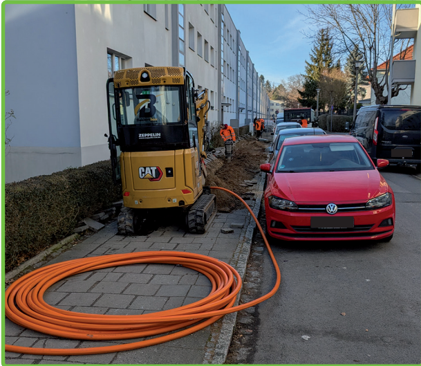
Verlegung von Glasfaserkabel auf der Fraunhoferstraße Foto: WGTN
